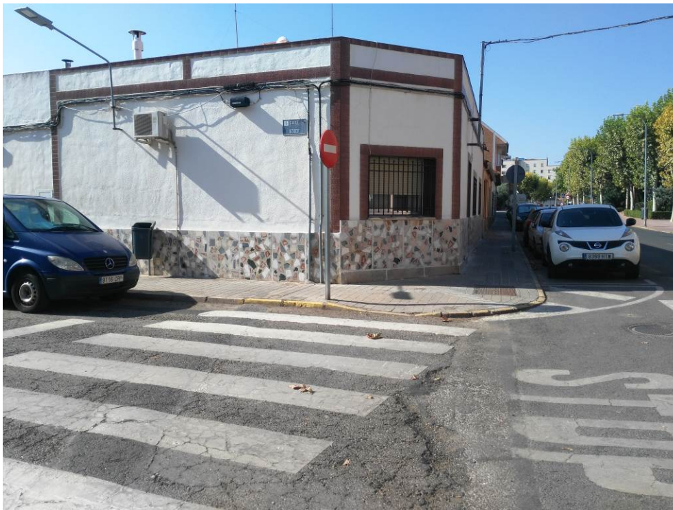
Paso de peatones al final de calle Azuer sin vado peatonal accesible en el acerado izquierdo.
