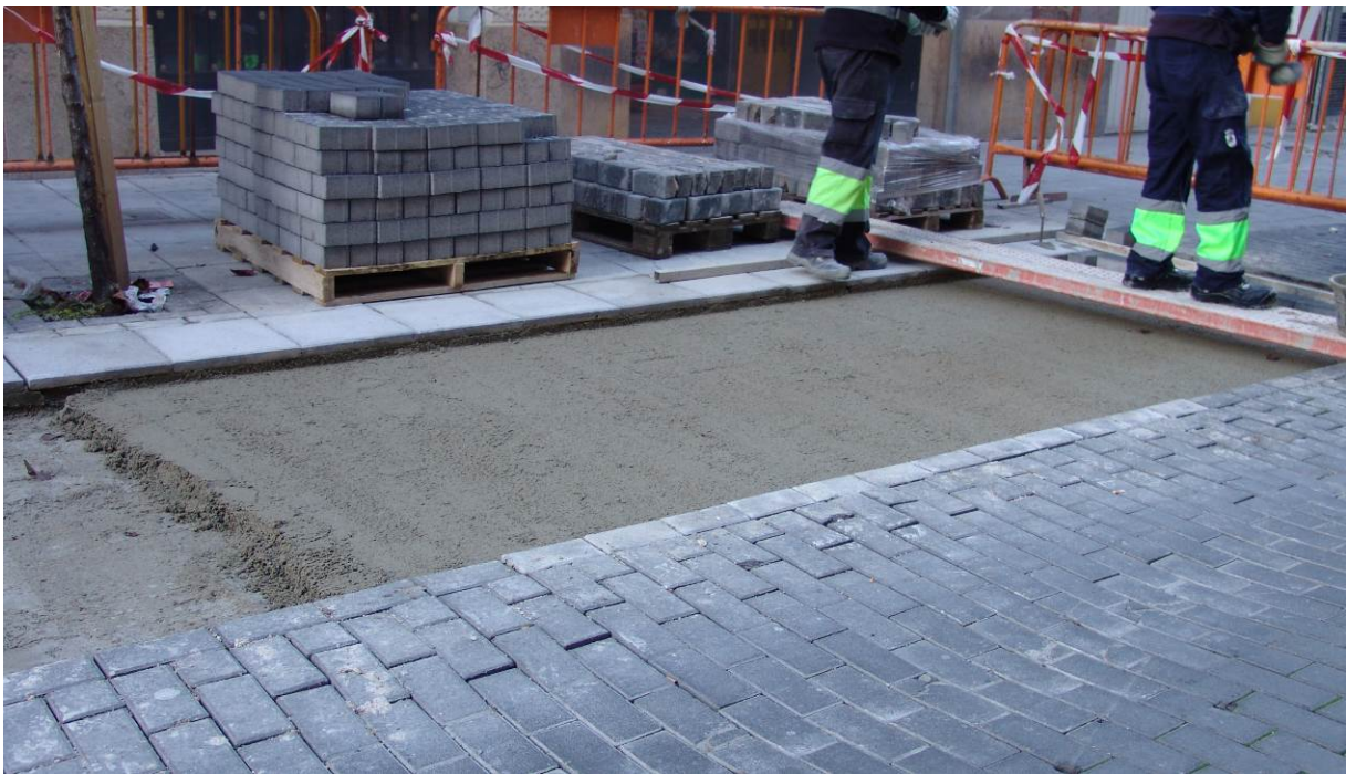
Capa de mortero para el asiento del pavimento de adoquín.
