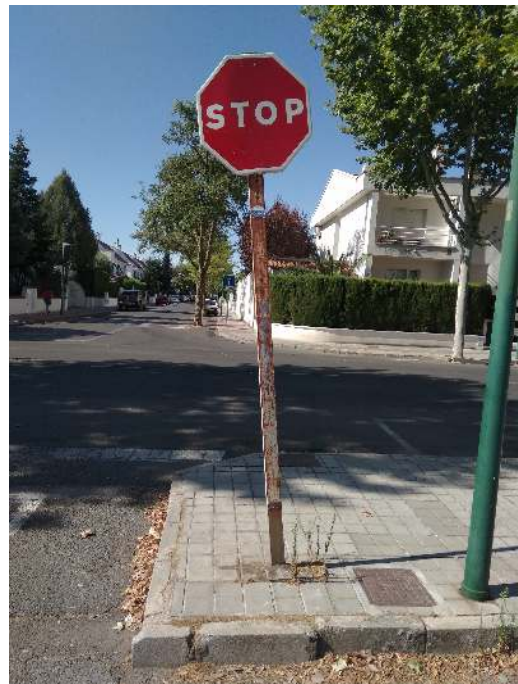
Foto 12.: Señalización vertical en mal estado. Poste oxidado
