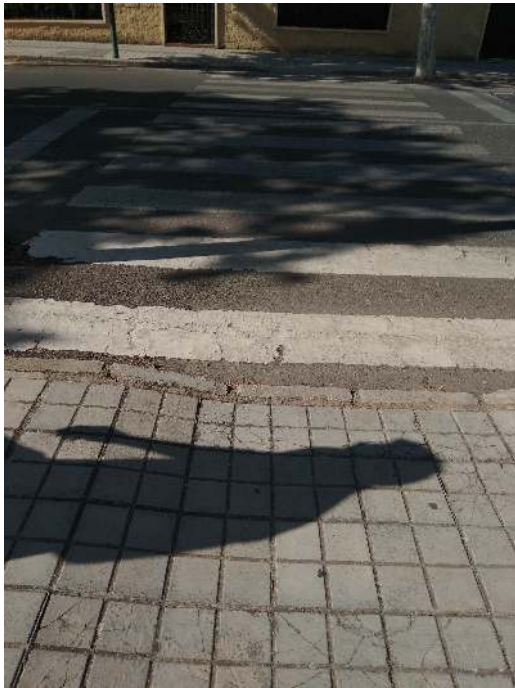
Foto 5.: Paso de peatones
